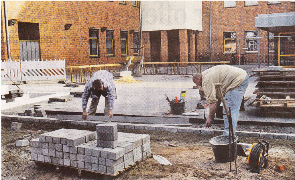
Die Mitarbeiter eines örtlichen Pflasterbetriebes gehen davon aus, dass die neue Multifunktionsfläche auf dem Pausenhof des MDG in spätestens zwei Wochen genutzt werden kann.
